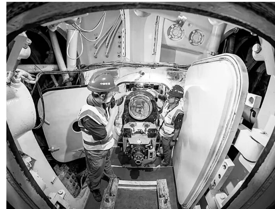
厦金大桥（厦门段）环岛路隧道“厦金号”盾构机掘进现场，工作人员在调试设备。科技日报发 受访单位供图
