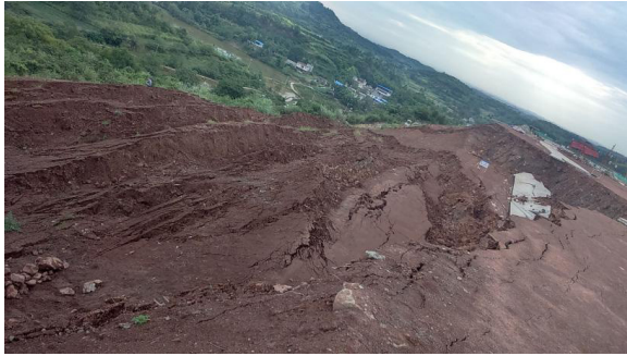
照 3-1 清方前填方土大面积垮塌（镜向下）
